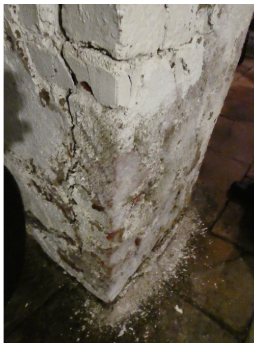
Bild 1: Kellerinnenwand im Altbau
